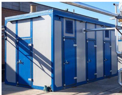
Рисунок 14 – Модуль поділу повітря станції ААВН-40/25 У1
