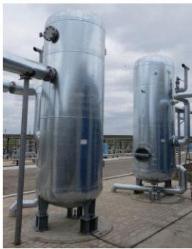
Рисунок 16 – Резерви повітря і азоту станції ААВН-40/25 У1
