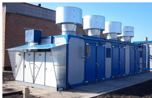
Рисунок 15 – Модуль компресора високого тиску станції ААВН-40/25 У1
