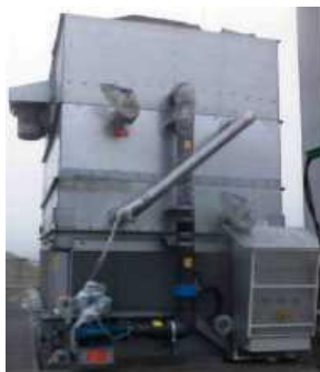
Рисунок 5 – Градирня з автоматичним насосним вузлом
