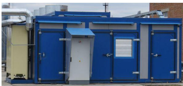
Рисунок 12 – Модуль компресора низького тиску станції ААВН-40/25 У1
