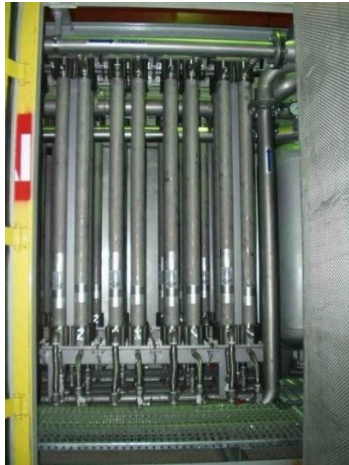
Рисунок 22 – Мембранний модуль станції АМГП-15/0,7 С У1
